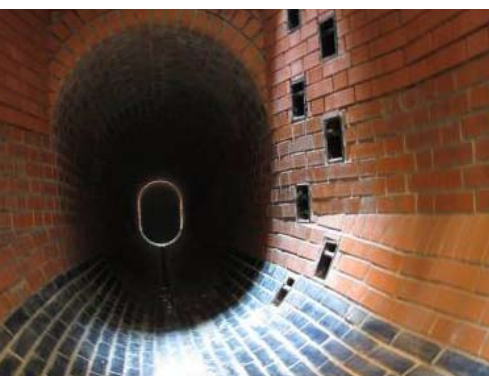
Obr. 5 Propoj do stoky „K“ (profil 1200/1800 mm)
