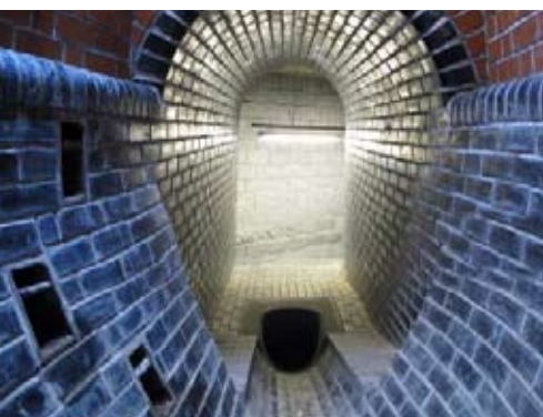
Obr. 3 Nátok do komory spadištěm
